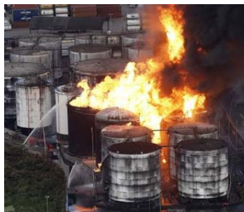
DEPOSITI DI COMBUSTIBILE
