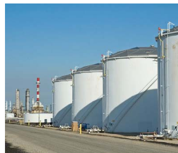
DEPOSITI DI COMBUSTIBILE
